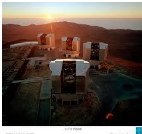
شکل (۱۰) تلسکوپ VLTI بر فراز کوه پارانال در کشور شیلی که از ۴ آینه جداگانه هرکدام به قطر ۸/۲ متر ساخته شده و به صورت تداخل سنجی کار می‌کند
